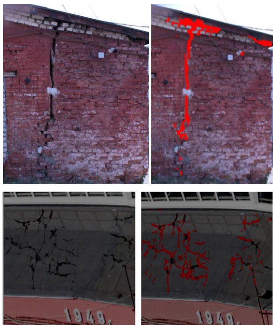
Рис. 2. Результаты сегментации нейросетевым алгоритмом
